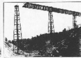
EN OBRA — Imagen del taller de la construcción del viaducto.
